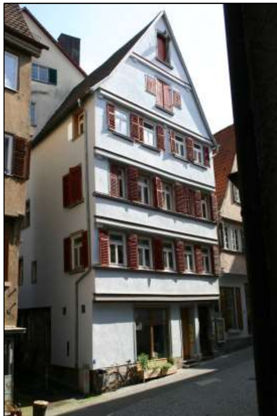
Abb. 2: Geltungsbereich – Gebäude (©Umweltzentrum Tübingen e.V.)
